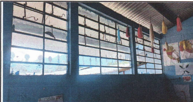
Foto 6: Sustitución de ventana de metal
