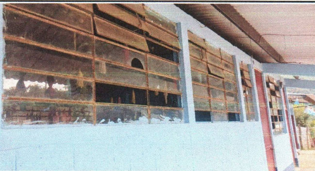
Foto 5: Sustitución de ventana de metal
