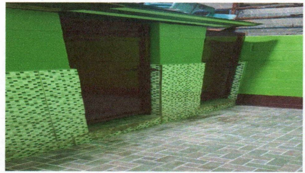
Foto 2: Sustitución de puertas para baños
