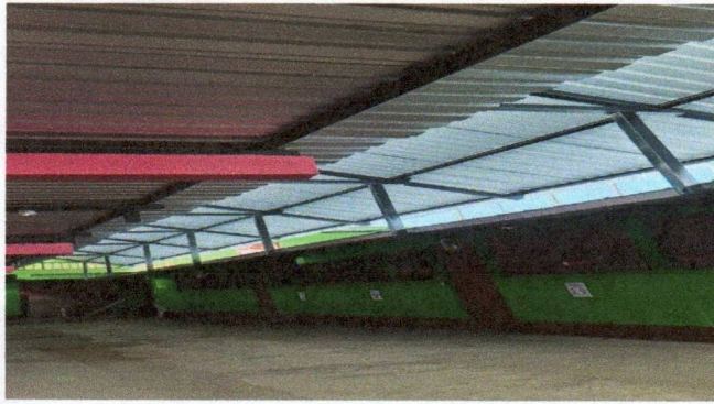
Foto:7 Sustitución de canal pvc y bajada de agua pluvial
