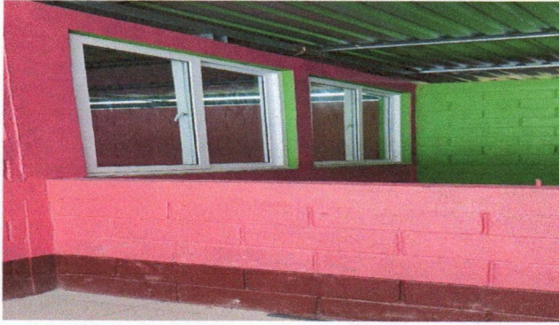
Foto1: Sustitución de ventanas
