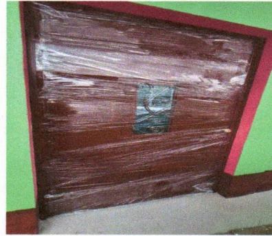
Foto:8 Mejoramiento de puerta para aula
