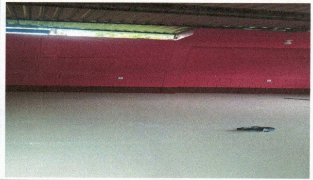
Foto 4: Sustitución de piso por granito
