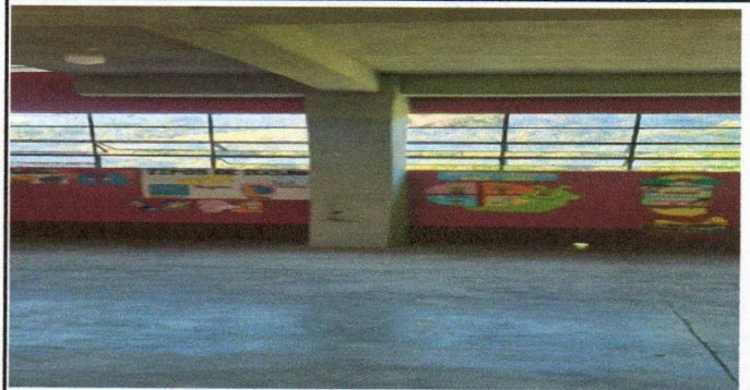
Foto 6: Mejoramiento de repello en cielo y columnas
