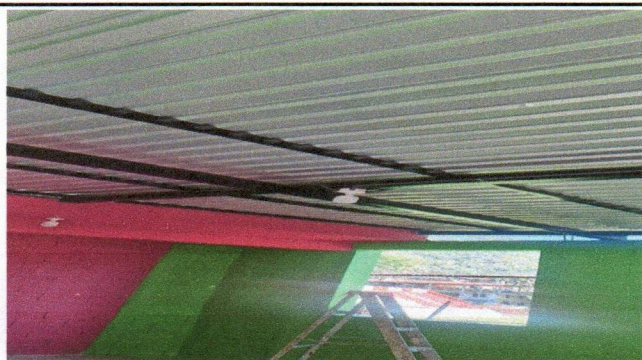
Foto 3: Mantenimiento a estructura de soporte de metal
