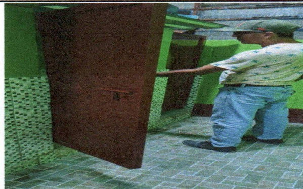
Foto 2: Sustrucción de puertas para baños
