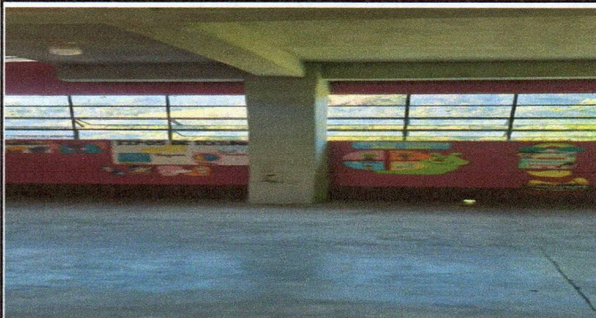
Foto 6: Mejoramiento de repello en cielo y columnas
