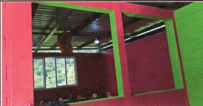
Foto 1: Sustrucción de ventanas
