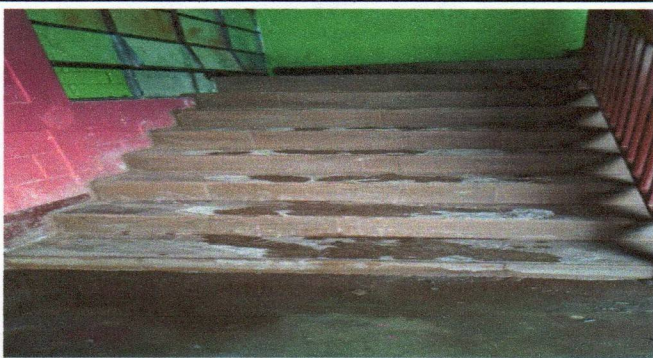
Foto 5: Mejoramiento de piso de granito para gradas
