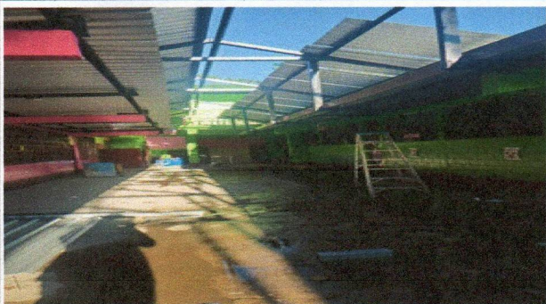
Foto:7 Sustitución de canal pvc y bajada de agua pluvial
