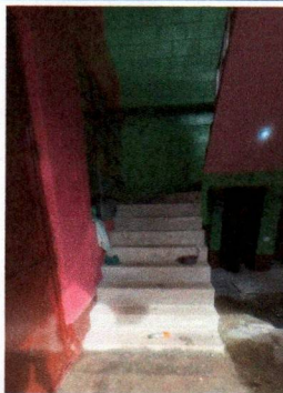
Foto 5: Mejoramiento de piso de granito para gradas
