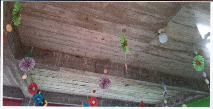
Foto 6: Mejoramiento de repello en cielo y columnas
