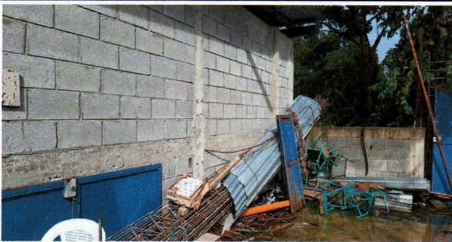
Foto 3: Mantenimiento a estructura de soporte de metal
