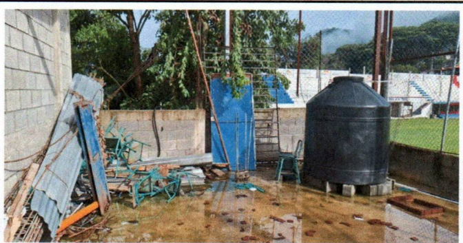
Foto 4: Sustitución de piso por granito
