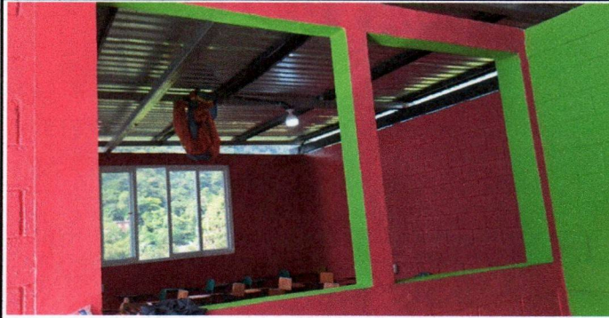
Foto1: Sustitución de ventanas
