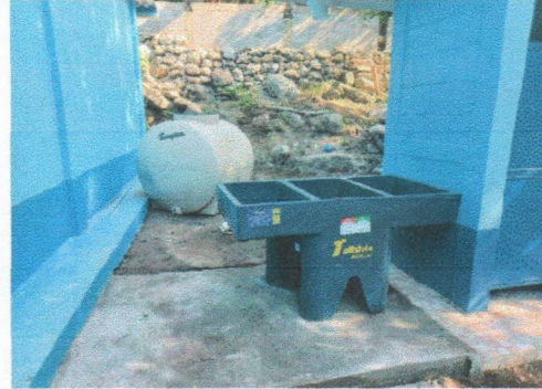
Foto8: SUSTITUCION DE PILA PLASTICA DE 2 LAVADEROS
