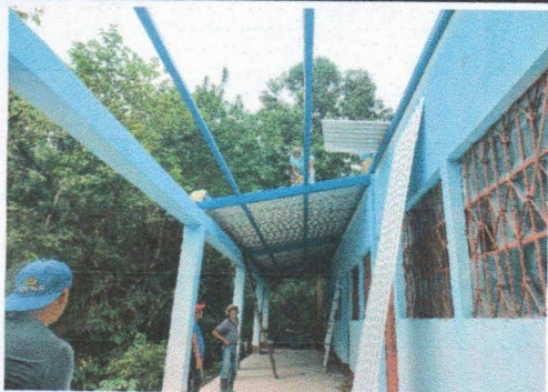
Foto1: SUSTITUCION DE LAMINA
