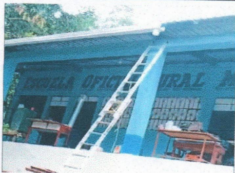
Foto5: SUSTITUCION DE CANAL PVC
