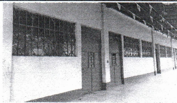
Foto 4: PINTURA EN MUROS EXTERIORES E INTERIORES
