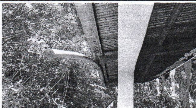
Foto 3: SUSTITUCION DE CANAL DE PVC
