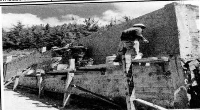
Foto1: Repello En muro de dentro y fuera del centro educativo
