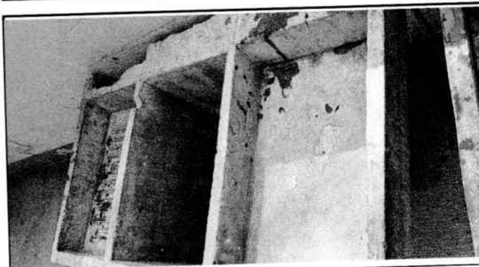
Foto 4: Sustitución de pila
