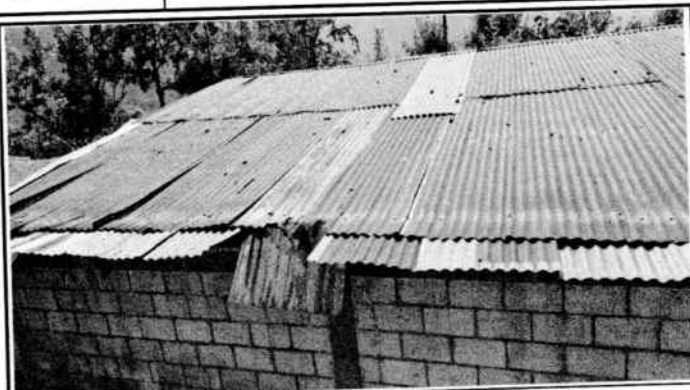
Foto 2: Sustitución de lamina en el centro educativo.
