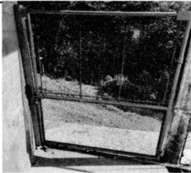
FOTO 7: Mantenimiento de portón de entrada de acceso
