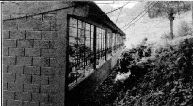
FOTO 2 Reconstrucción de Pared
