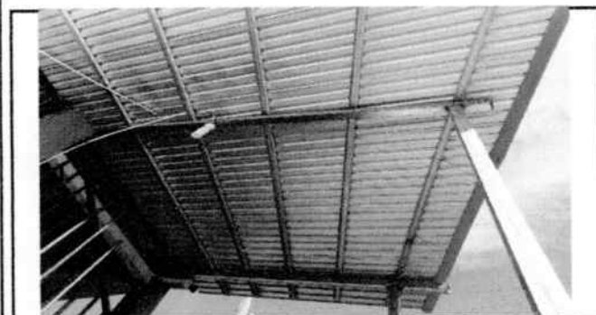
FOTO5 Sustitución de lámina por lámina aluzin calibre 26
