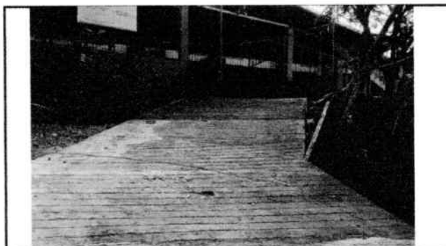
FOTO 4 Reparación de concreto de la entrada principal
