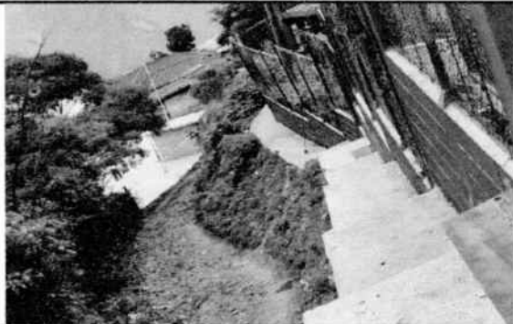
FOTO 9 Sustitución de torta de concreto en banquetas
