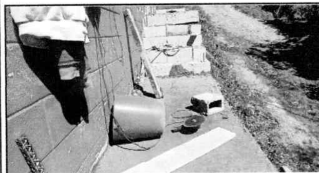
FOTO 9 Sustitución de torta de concreto en banquetas
