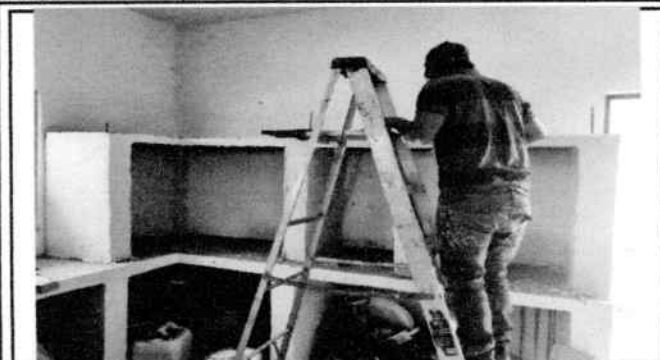
FOTO 1 Mesa de concreto para cocina
