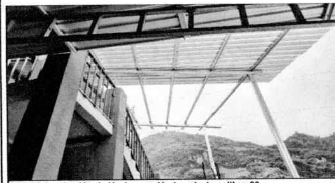
FOTO5 Sustitución de lámina por lámina aluzin calibre 26
