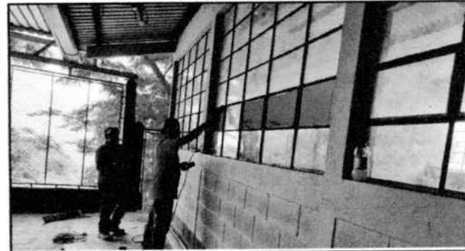
FOTO 10 Sustitución de vidrios de Ventana
