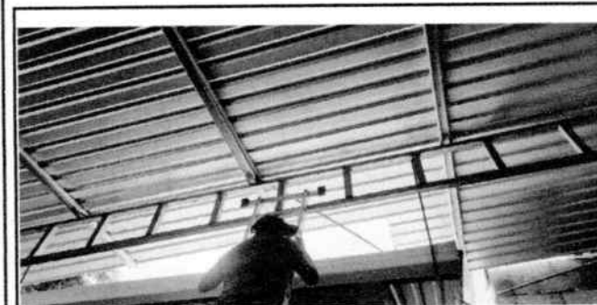
FOTO 11 Sustitución de ducto electrico más accesorios
