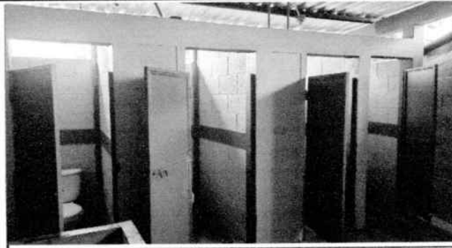
FOTO 8: Mantenimiento y reforzamiento de puertas de baño
