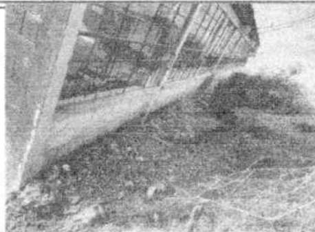
FOTO 2: Reparación de pared
