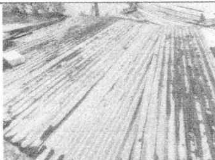
FOTO 5: Sustitución de lámina por lámina aluzin calibre 26
