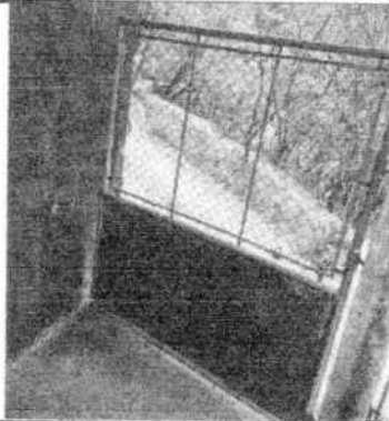
FOTO 7: Mantenimiento de portón de entrada de acceso
