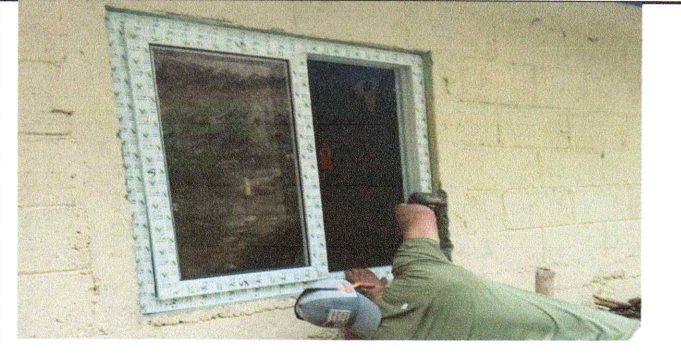
Foto 4: Sustrucción de ventanas terminado
