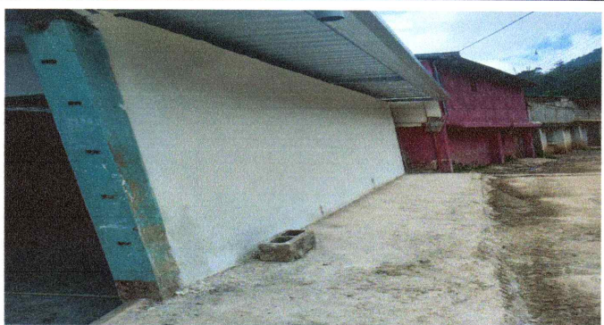
Foto 3: Canal de agua de metal terminado
