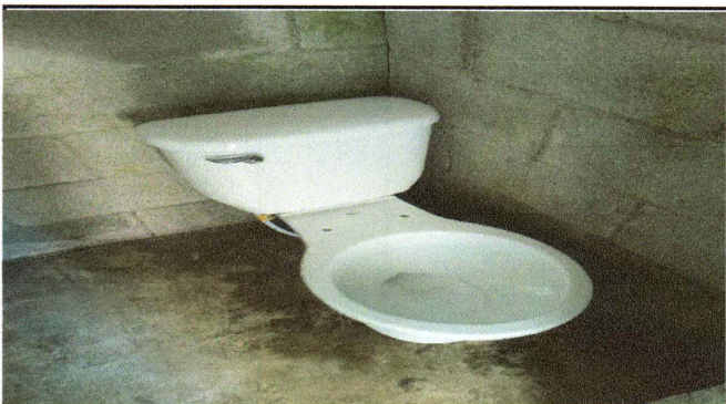
Foto 5: Sustrucción de inodoro terminado
