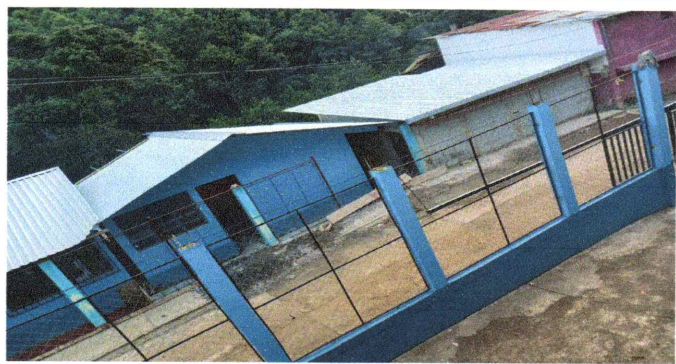
Foto 1 Sustrucción de laminas de aulas terminado
