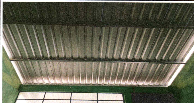
Foto 2: Sustrucción de estructura de metal terminado
