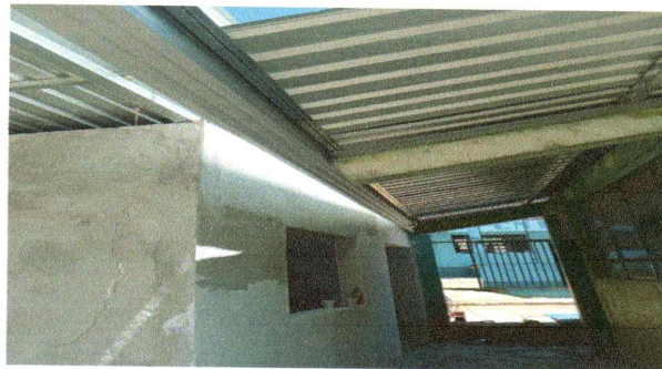
Foto 2: Sustitucion de estructura de metal en proceso
