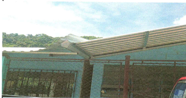
Foto 4: Sustitucion de ventanas en proceso
