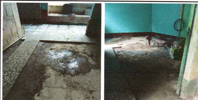
Foto 6: Mejoramiento de piso por piso granito en proceso
