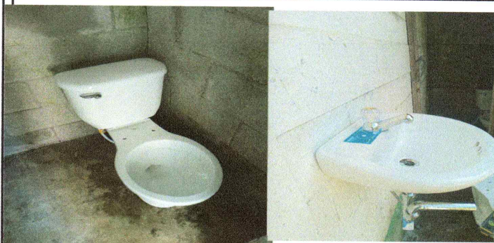
Foto 5: Sustitucion de inodoro en proceso
