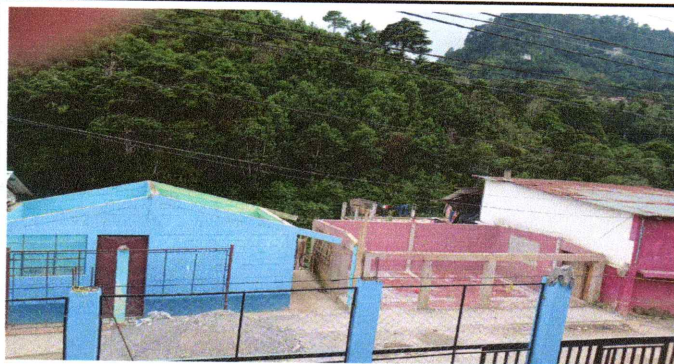
Foto 1 Sustitucion de laminas de aulas en proceso
