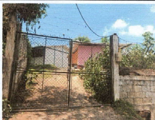
Foto 2: Se realizará la sustitución del portón de metal de ingreso, y así contar con mayor seguridad de las instalaciones del centro educativo.
