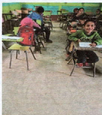
Foto 3: Se sustituirá la plancha de concreto en las aulas, por porcelanato de alto tráfico, para un ambiente más agradable, buena higiene y facilidad realizar limpieza.
