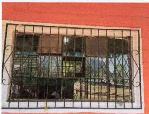
Foto 1: Se realizará mantenimiento a estructura de metal de ventana y sustitución de vidrios, para mayor seguridad de las aulas del centro educativo.
