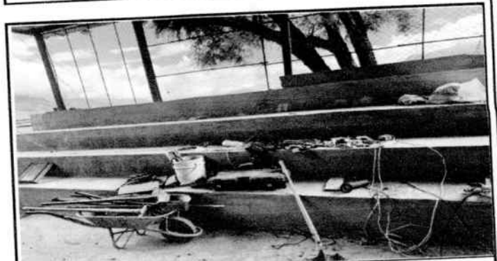
Reparación de planchas de concreto de patio
