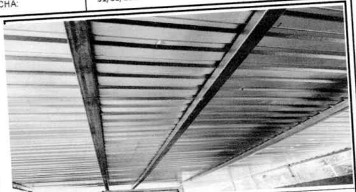
Sustitución de Estructura de Soporte de metal, por metal
