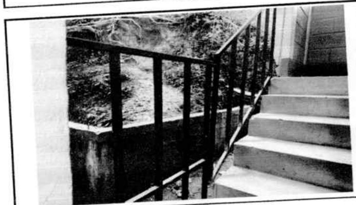
Sustitución de barandas de metal
