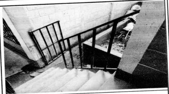
Sustitución de barandas de metal
