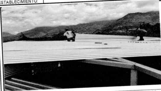
Foto 1: Sustitución de lámina por lámina troquelada aluzinc calibre 26 en módulo 1
