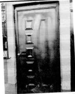
Sustitución de Puertas de metal (3 de 1.10*2 y 1 de 0.65*2)
