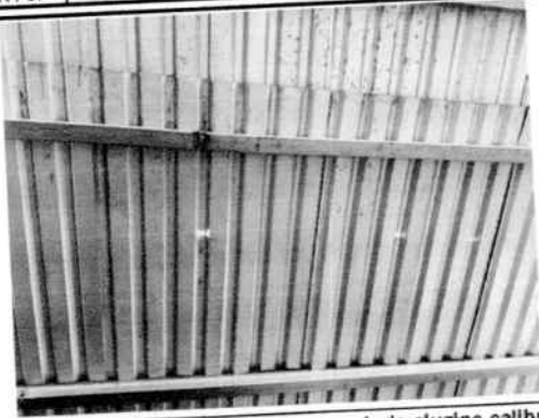
Foto 1: Sustitución de lámina por lámina troquelada aluzinc calibre 26 en módulo 1
