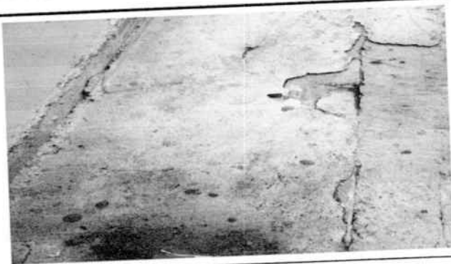
Reparación de planchas de concreto de patio
