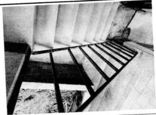
Sustitución de barandas de metal
