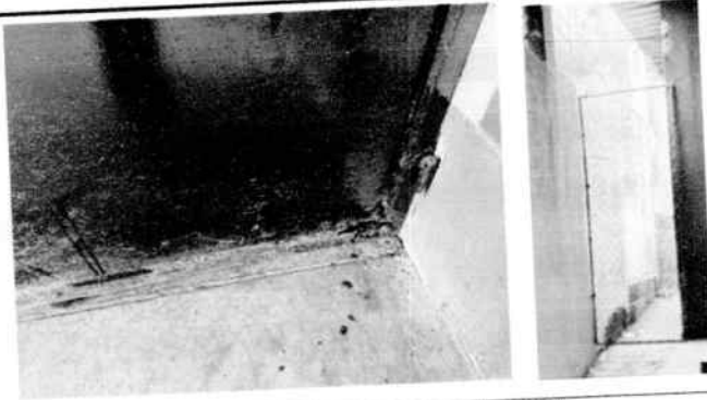
Sustitución de Puertas de metal (3 de 1.10*2 y 1 de 0.65*2)
