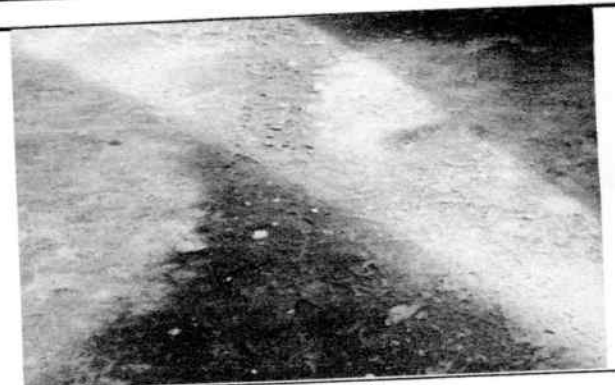
Reparación de planchas de concreto de patio
