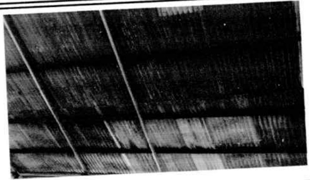
Sustitución de Estructura de Soporte de metal, por metal
