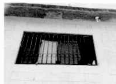
Foto 2: Sustitucion de balcones de metal
