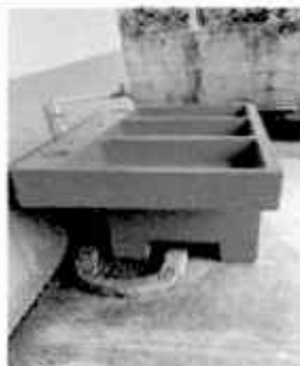
Foto 5: Sustitución de Pila de cemento de dos lavamanos
