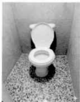
Foto1: Sustitución de inodoros con sus accesorios
