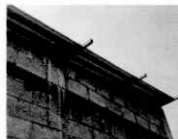
Foto 6: Sustitucion de canal de metal
