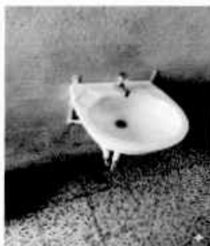
Foto 3: Sustitución de lavamanos
