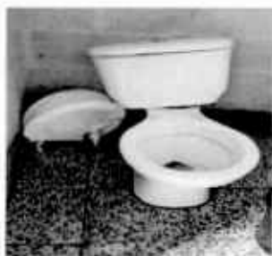
Foto1: Sustitución de inodoros con sus accesorios
