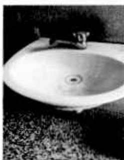
Foto 3: Sustitución de lavamanos
