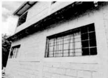
Foto 2: Sustitucion de balcones de metal
