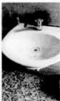
Foto 3: Sustitucion de lavamanos .
