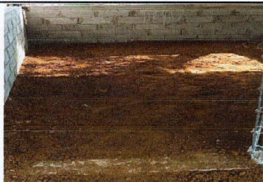
Foto 1: Mejoramiento de piso en cocina
