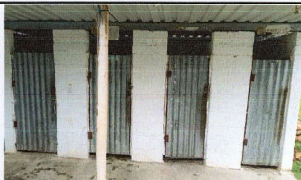
Foto 2: Sustitución de puertas de baños de la escuela
