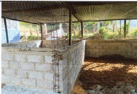
Foto 1: Mejoramiento de pared en cocina
