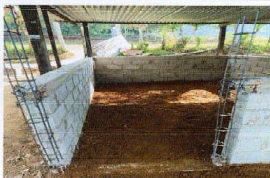
Foto 3: Mejoramiento de puertas de metal en cocina
