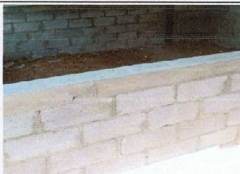
Foto 5: Sustitución de repello en pared de cocina
