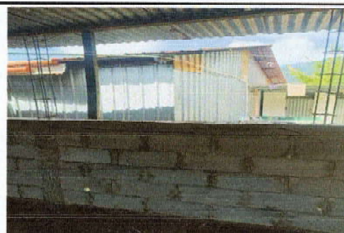
Foto 6: Mejoramiento de Ventanas en cocina
