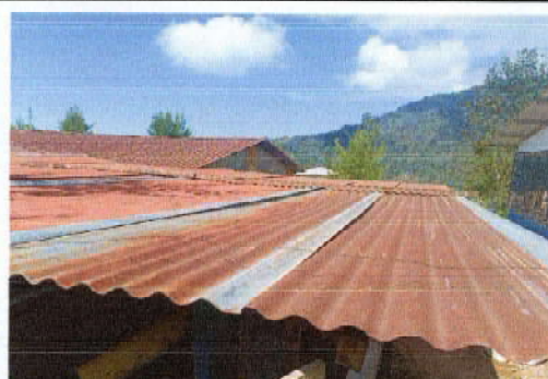
Foto 4: Sustitución de cubierta de lamina en cocina
