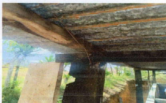
Foto 5: Sustitución de estructura de techo
