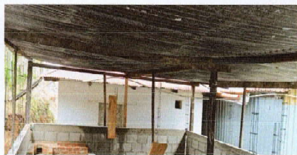
Foto 4: Mejoramiento de cableado eléctrico.
