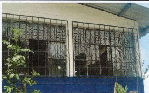
Foto 3: Mejoramiento de ventanas en edificio escolar
