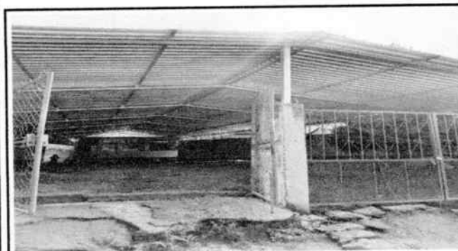
Foto 3: Techo ya instalado
