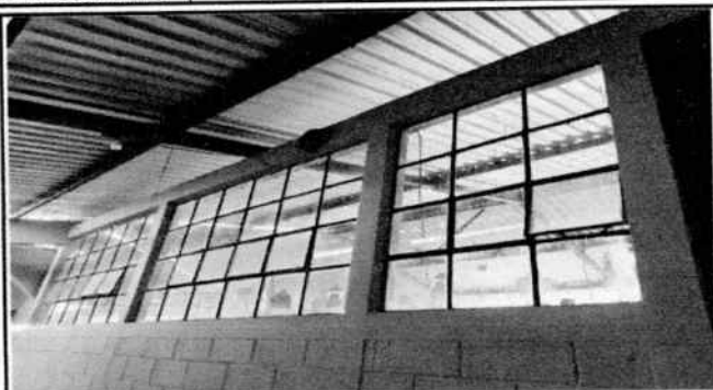
Foto1: Vidrios sustituidos
