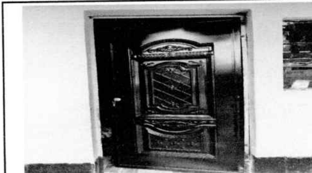
Foto 2: Puertas ya sustituidas.
