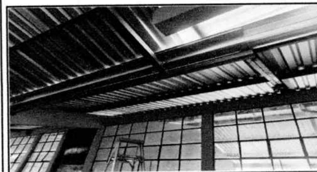
Foto 5: Canales ya instalados.
