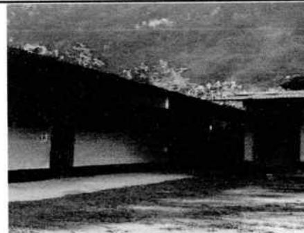
Foto 2: Puertas que se cambiaron
