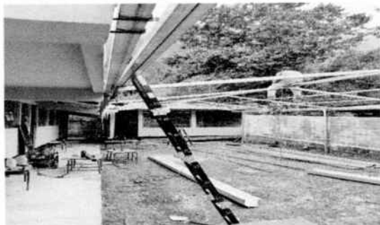
Foto 3: Cambio de techo en mal estado
