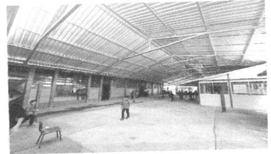
Foto 2: Renglón 2. Estructura de Techo.
