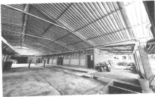
Foto1: Renglón 1. Cubierta de Lámina
