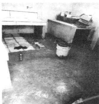
Foto 3: Renglón 6. Sustitución de piso de torta de concreto por granito
