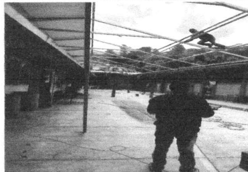
Foto 2: Renglón 2. Estructura de Techo.
