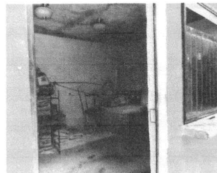
Foto 4: Renglón 9. Pintura en muros exteriores e interiores
