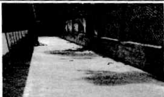
Foto 5: Reparación y mantenimiento de muro perimetral parte trasera de aulas
