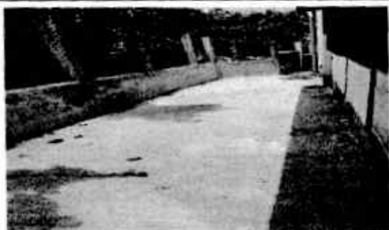
Foto 1: Reparación y restauración de plancha de concreto parte de atrás de aulas.
