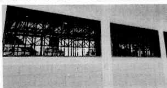
Foto 2: Sustitución de balcones de ventanas
