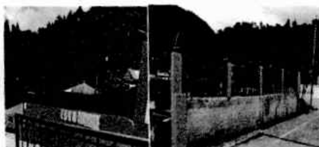
Foto 11: Mejoramiento e instalación de barandales.
