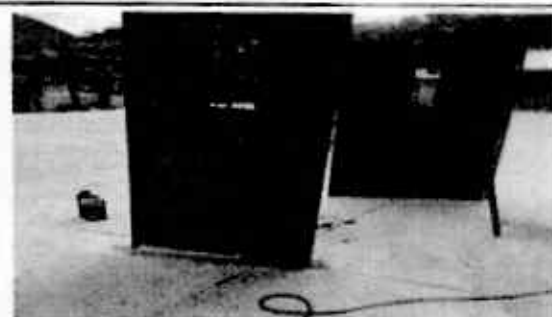
Foto 4: Reparación de puertas
