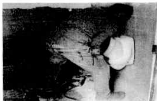
Foto 8: Mejoramiento e instalación de mingitorios.
