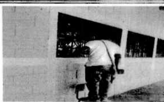
Foto 2: Sustitución de balcones de ventanas.
