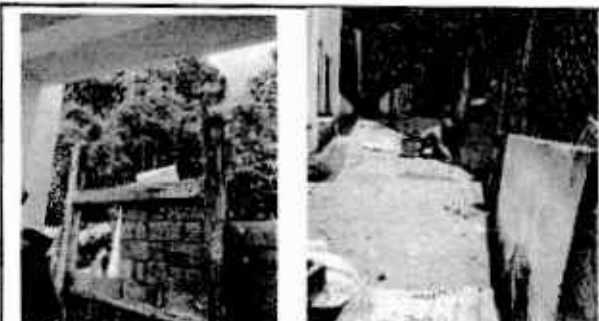
Foto 5: Reparación y mantenimiento de muro perimetral parte trasera de aulas
