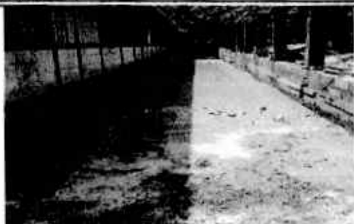
Foto 1: Reparación y restauración de plancha de concreto parte de atrás de aulas.
