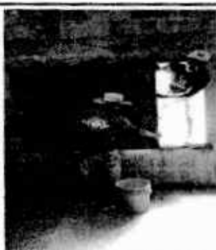
Foto 9: Mejoramiento de repello de pared de cocina e instalación de ventana de metal.
