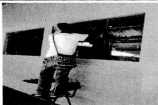
Foto 7: Sustitución de vidrios en ventanas.
