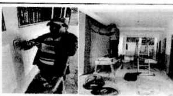
Foto 6: Mejoramiento en instalación de electricidad
