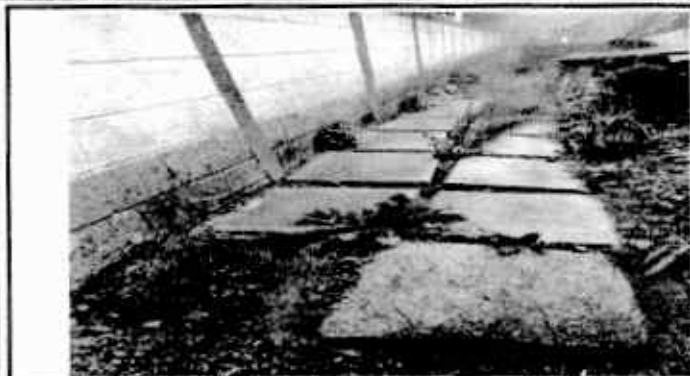
Foto 1: Reparación y restauración de plancha de concreto parte de atrás de aulas.
