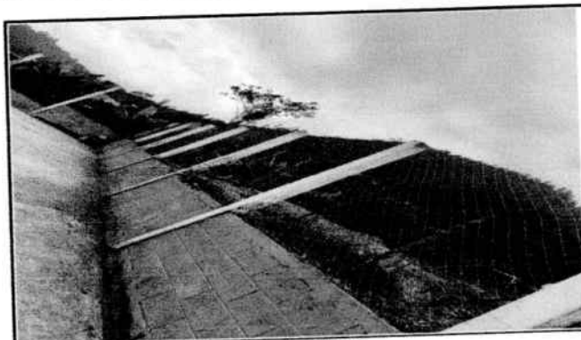
Reparación de tubo hp y malla galvanizada
