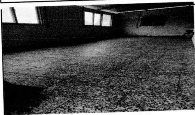
Sustitución de piso de cemento por piso de granito para la cocina
