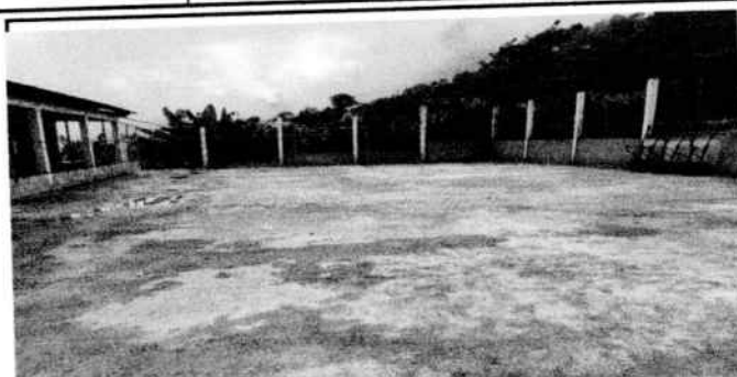
Sustitución de patio de losa
