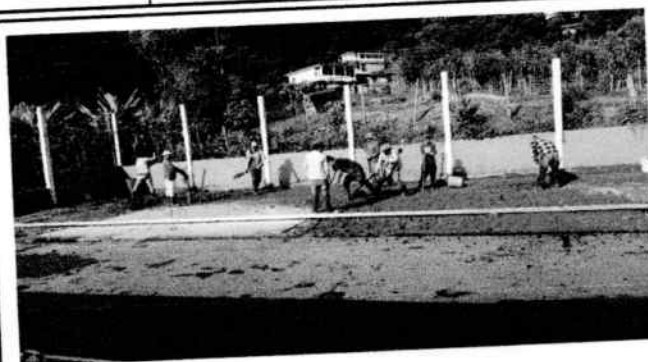
Sustitución de patio de losa
