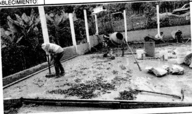
Sustitución de planchas de concreto
