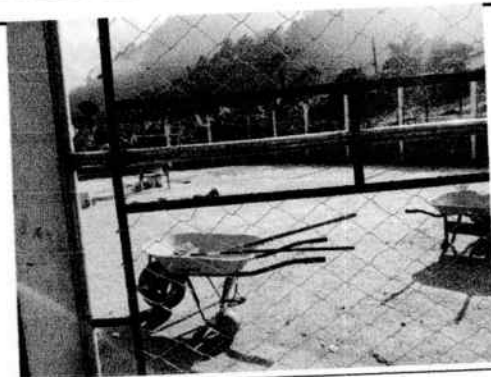
Reparación de tubo hp y malla galvanizada
