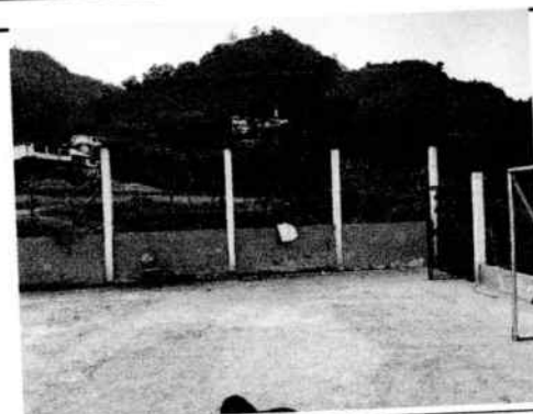
Reparación de tubo hp y malla galvanizada
