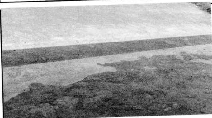
Sustitución de piso de cemento por piso de granito para la cocina
