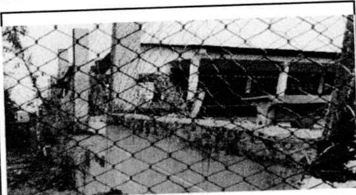
Reparación de tubo hp y malla galvanizada
