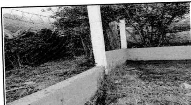
Reparación de tubo hp y malla galvanizada
