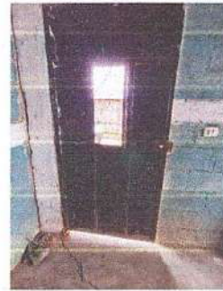
Foto 4: Sustrucción de chapa renglón 4.2
