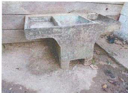
Foto 11: Sustitución de pila de cemento de dos lavaderos renglón 20.10
