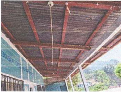
Foto 1: Sustrucción de estructura de soporte de madera, por metal renglón 2.1
