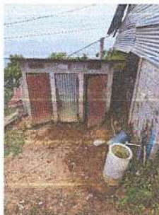
Foto 5: Sustrucción de puerta en servicios sanitarios de 0.90 cm. de ancho X 1.85 cm. renglón 4.4
