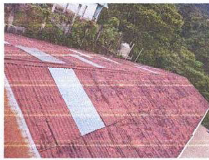
Foto 2: Sustrucción de lámina por lámina troquelada aluzinc calibre 26 renglón 1.1
