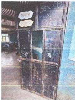
Foto 3: Mantenimiento a estructura de puertas de 2.10m * 0.90m (lijado, cambio de tubo, cepillado, sujeciones, aplicación de pintura) renglón 4.1
