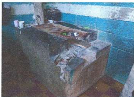
Foto 7: Mantenimiento de estufa rural renglón 20.1
