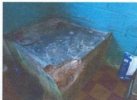
Foto 10 : Sustitución de azulejo en lavadero rural de cocina renglón 20.8
