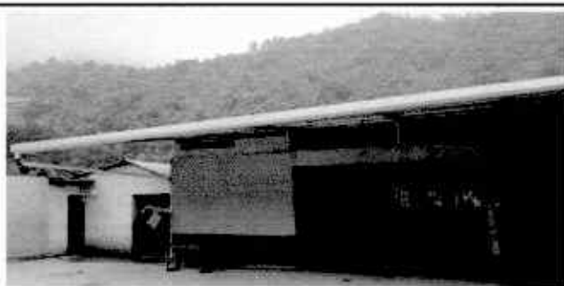
Foto 5: Sustitución de canales de metal
