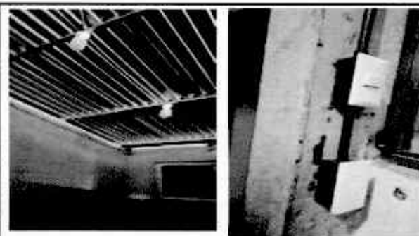
Foto 6: Sustitución de cableado eléctrico
