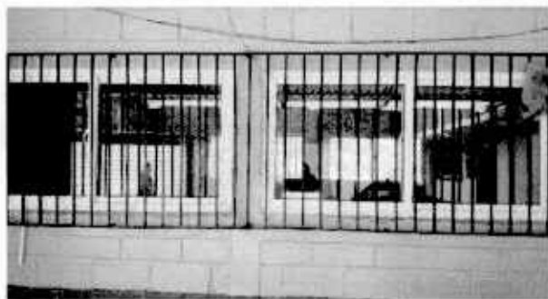
Foto 3: Sustitución de ventanas de metal por ventanas de PVC
