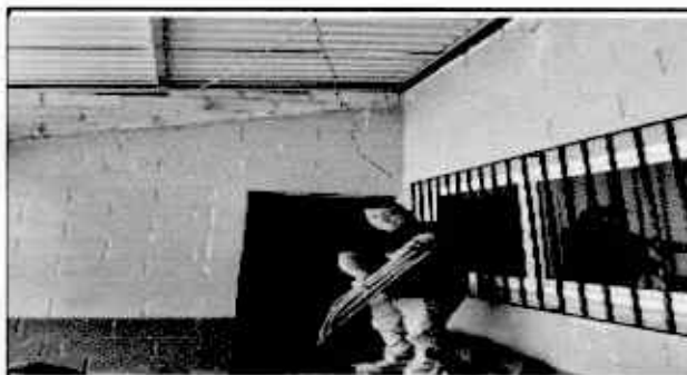
Foto 6: Sustitución de cableado eléctrico
