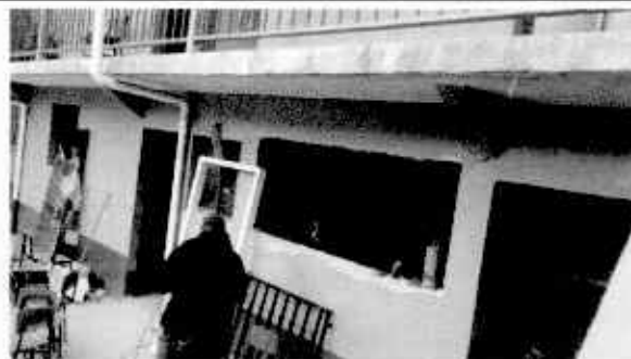
Foto 2: sustitución de puertas de metal por puertas de metal
