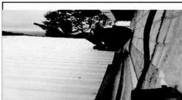
Foto 5: Sustitución de canales de metal
