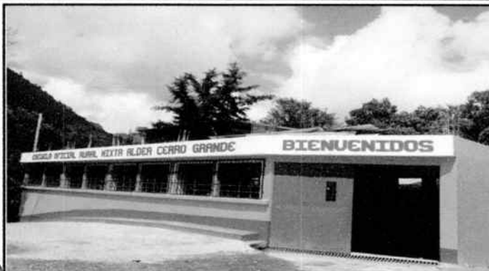
Pintura de muros y rotulación
