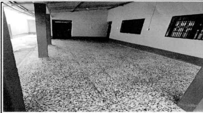
Colocación de piso de granito
