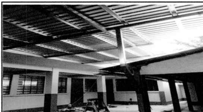
Colocación de techo y estructura metálica
