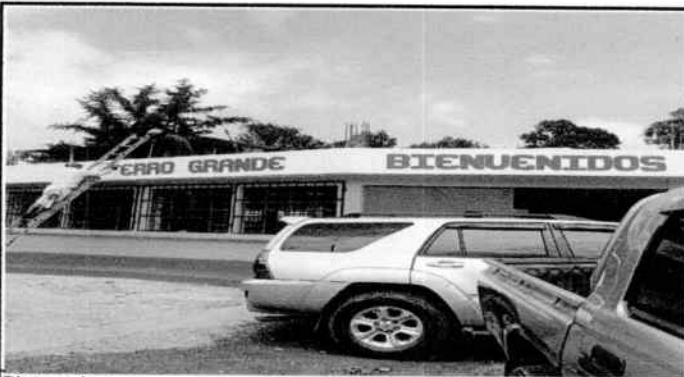
Pintura de muros
