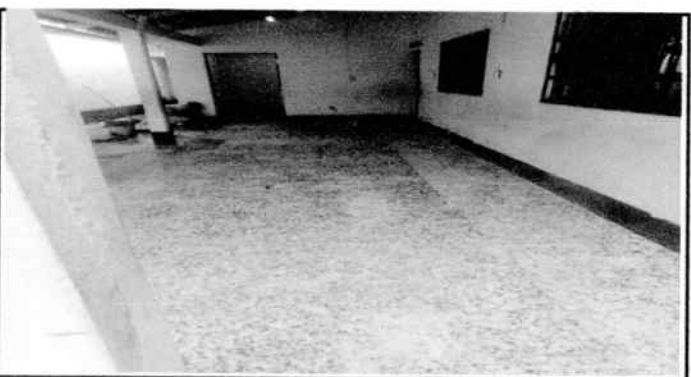
Colocación de piso de granito
