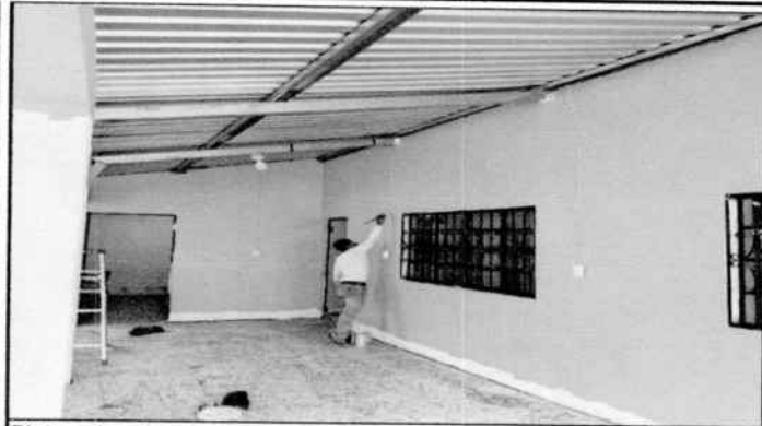
Pintura de aulas
