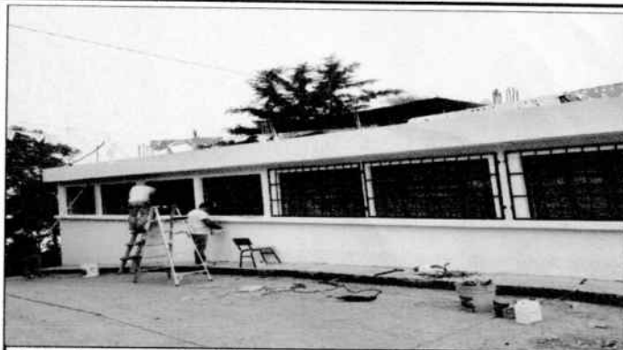
Pintura de muros perimetrales
