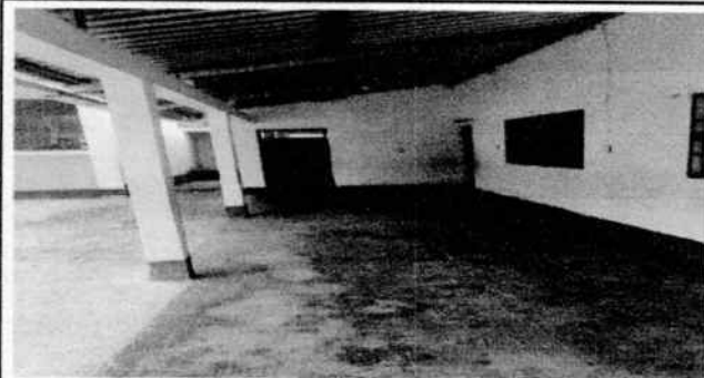
Foto 1, Sustitución de piso.
