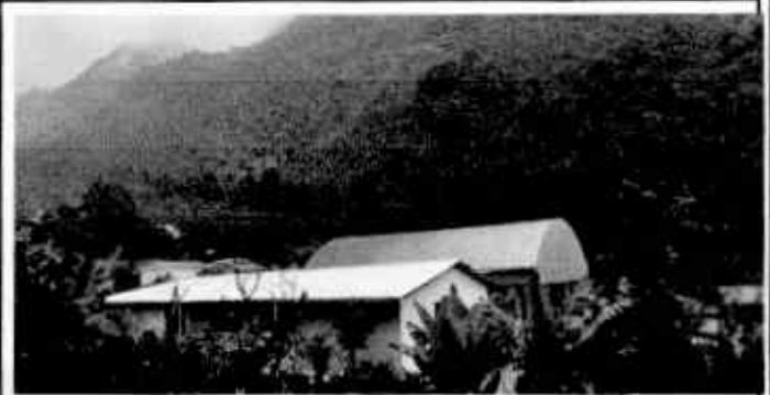
Foto 2: Renglón 1. Cubierta de Lámina
