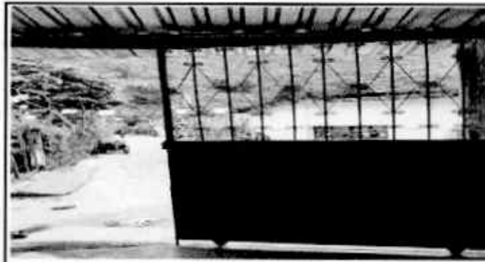
Foto 4: Renglón 5. Mantenimiento a Portones
