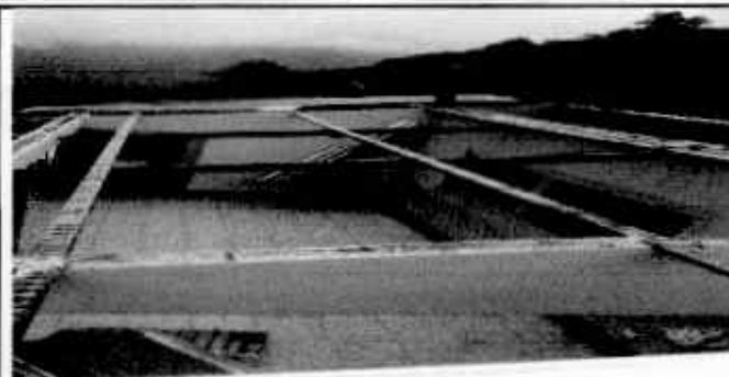
Foto 2: Renglón 1. Cubierta de Lámina
