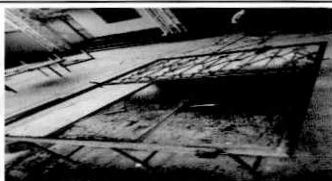
Foto 3: Renglón 5. Mantenimiento a portones
