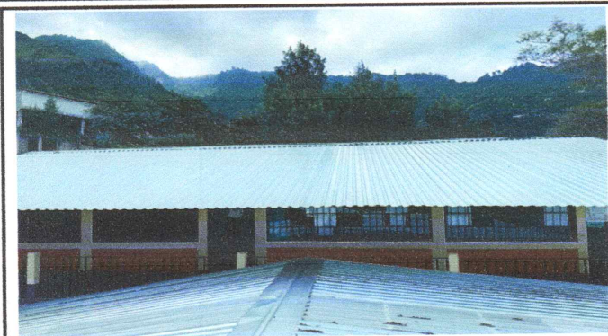
Foto 1: Sustitución de lámina por lámina troquelada aluzinc calibre 26 en módulo 1
