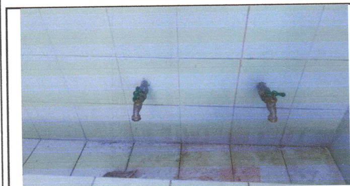
Foto 5: Sustitución de llaves lavamanos
