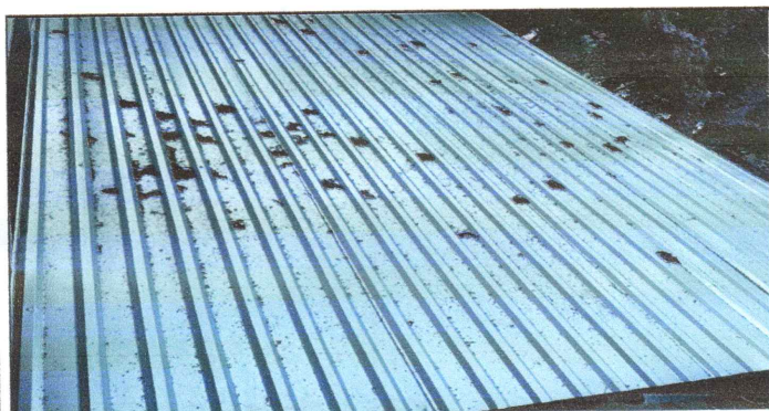
Foto 3: Sustitución de lámina por lámina troquelada aluzinc calibre 26 en modulo 3
