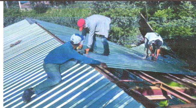
Foto 2: Sustitución de lámina por lámina troquelada aluzinc calibre 26 en modulo 2
