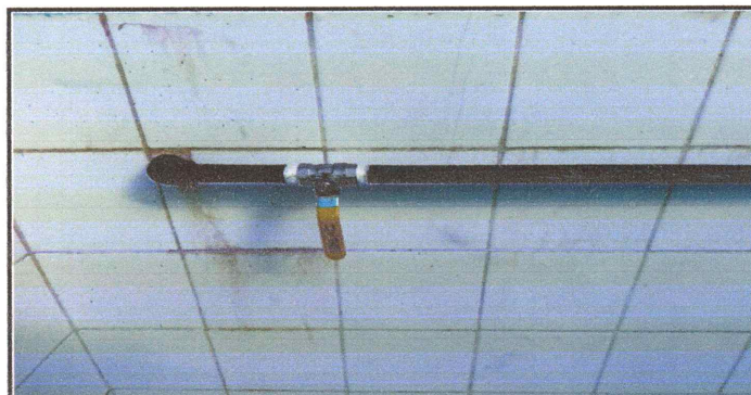
Foto 6: Sustitución de llave de mingitorio
