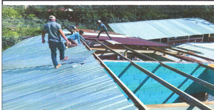
Foto 1: Sustitución de lámina por lámina troquelada aluzinc calibre 26 en módulo 1
