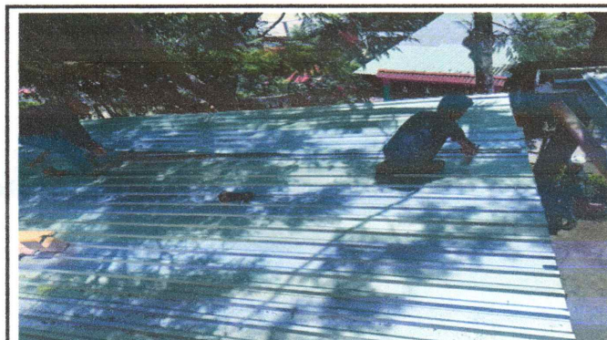
Foto 3: Sustitución de lámina por lámina troquelada aluzinc calibre 26 en modulo 3
