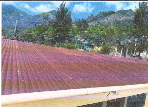
Foto 1: Sustrucción de lámina por lámina troquelada aluzinc calibre 26 en módulo 1
