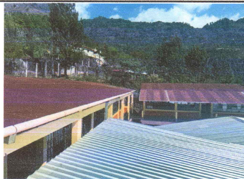
Foto 2: Sustrucción de lámina por lámina troquelada aluzinc calibre 26 en módulo 2
