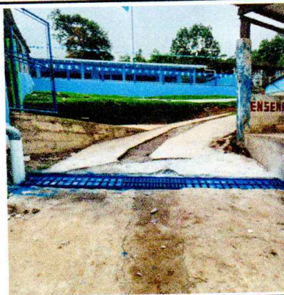
Foto 8: Se realizó reparación de rejilla metálica, para evitar accidentes.
