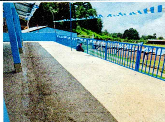
Foto 4: Se reparó la plancha de concreto de patio, ya que la anterior estaba en muy mal estado.
