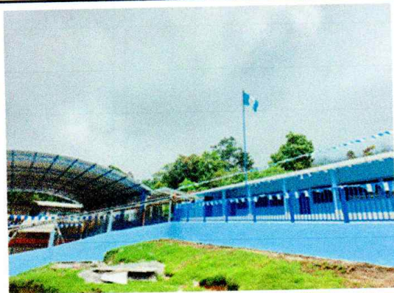
Foto 7: Se realizó sustitución de baranda de metal, para protección de los estudiantes y seguridad del centro educativo.
