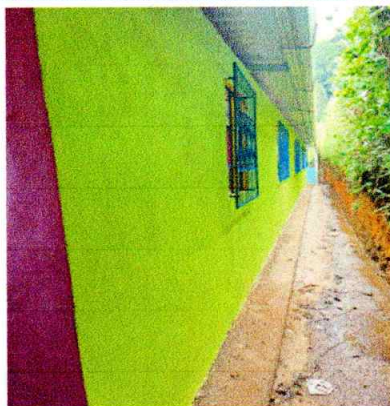
Foto 3: Se realizó reparación de cuneta de concreto, para mejorar la circulación del agua de la lluvia y así proteger las paredes de las aulas.
