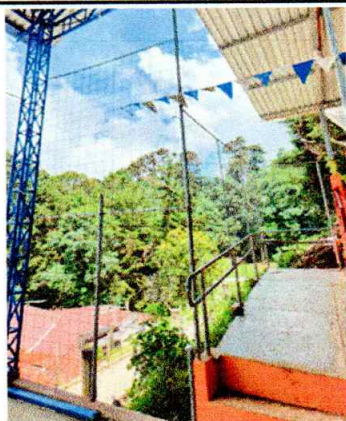
Foto 1: Se realizó reparación de cerco perimetral, para mayor seguridad de los niños, ya que se tenía registro de accidentes y heridos.
