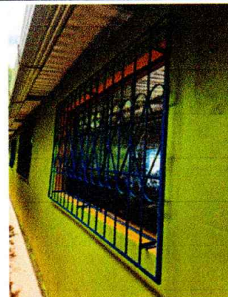
Foto 2: Se realizó mantenimiento a balcones, a estructura de metal de ventanas y cambio de vidrios y así contar con mayor seguridad en las aulas del centro educativo.
