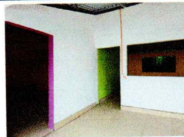
Foto 6: Se está realizando mantenimiento a puertas de ingreso de las aulas, para una mayor seguridad.
