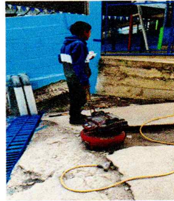
Foto 8: Se está realizando reparación de rejilla metálica, para evitar accidentes.
