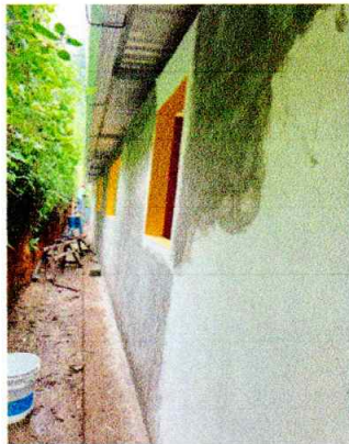
Foto 9: Se está realizando reparación de repello en pared, para protección de la misma.
