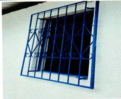
Foto 2: Se está realizando mantenimiento a balcones, a estructura de metal de ventanas y cambio de vidrios y así contar con mayor seguridad en las aulas del centro educativo.
