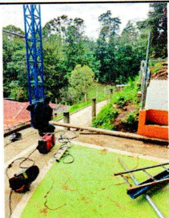
Foto 1: Se está realizando reparación de cerco perimetral, para mayor seguridad de los niños, ya que se han tenido registro de accidentes y heridos.
