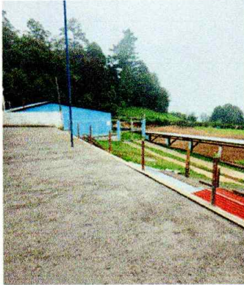
Foto 7: Se está realizando sustitución de baranda de metal, para protección de los estudiantes y seguridad del centro educativo.
