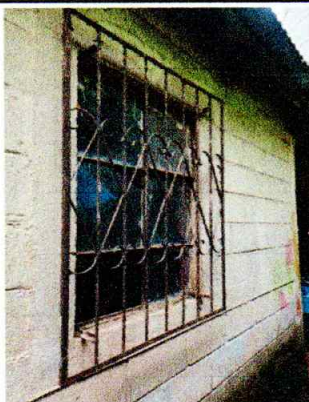
Foto 9: Se realizará reparación de repello en pared, para protección de la misma.
