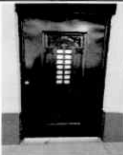
Foto 5: SUSTITUCIÓN DE PUERTAS
