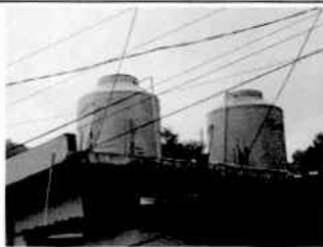
Foto 2: SUSTITUCIÓN DE DEPOSITO DE AGUA
