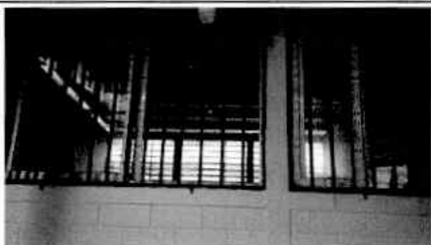
Foto 3: SUSTITUCIÓN DE BACONES DE METAL EN VENTANAS
