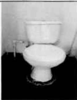
Foto 3: SUSTITUCIÓN DE INODOROS
