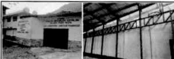
Foto 2: SUSTITUCIÓN DE LAMINAS POR LAMINAS TROQUELADAS CALIBRE 26
