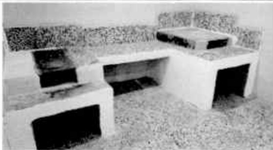
Foto 1: SUSTITUCIÓN DE ESTUFA RURAL COMPLETA CHIMENEA Y PLANCHA METAL
