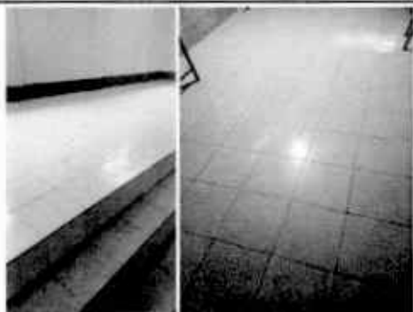
Foto 1: SUSTITUCIÓN DE PISO POR CERAMICO
