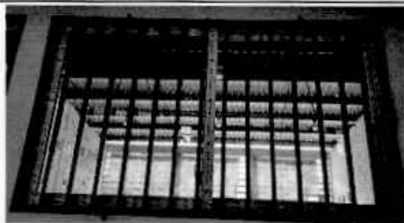
Foto 6: SUSTITUCIÓN DE ESTRUCTURA DE METAL DE VENTANA
