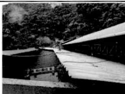
Foto 2: SUSTITUCIÓN DE LAMINAS POR LAMINAS TROQUELADAS CALIBRE 26
