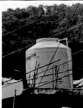
Foto 3: SUSTITUCIÓN DE DEPOSITO DE AGUA
