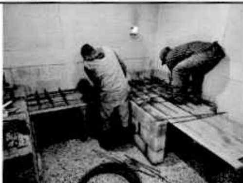
Foto1: SUSTITUCIÓN DE ESTUFA RURAL COMPLETA CHIMENEA Y PLANCHA METAL
