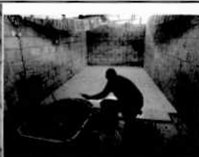
Foto1: SUSTITUCIÓN DE PISO POR CERAMICO
