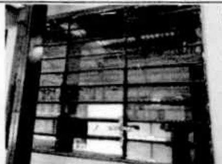
Foto 6: SUSTITUCIÓN DE ESTRUCTURA DE METAL DE VENTANA
