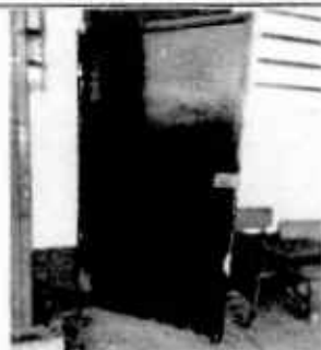
Foto 5: SUSTITUCIÓN DE PUERTAS
