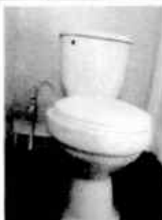
Foto 3: SUSTITUCIÓN DE INODOROS
